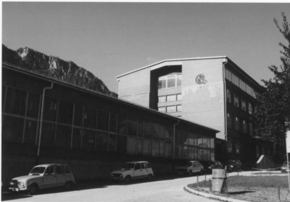
Leta 1977, ko je bila izvedena adaptacija tretjega nadstropja (Arhiv Srednje šole Jesenice)
