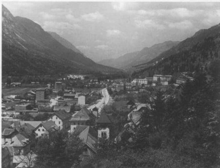
Jesenice z Murove proti prvim blokom na Plavžu
