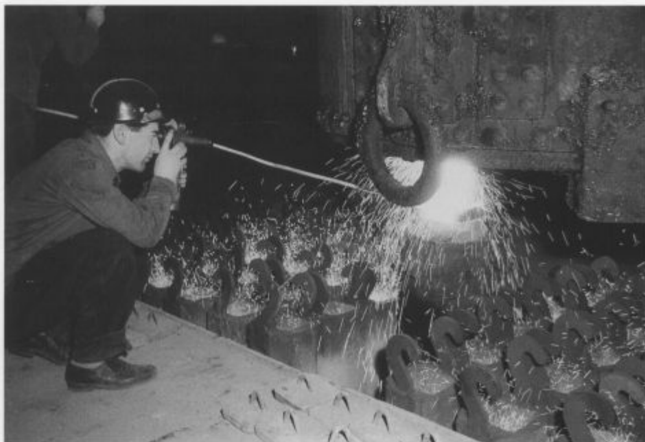
Merjenje temperature jekla v jeklarni z optičnim pirometrom leta 1964 (Fotografski arhiv GM Jesenice)
