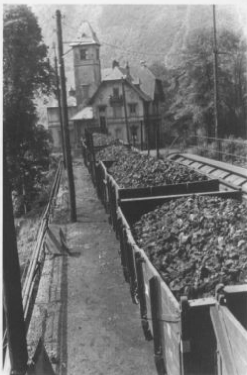
Dovoz koksa na rampo v Hrenovco leta 1963 (Arhiv GM Jesenice)
