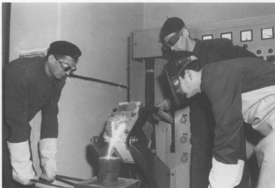
Vlivanje taline na visokofrekvenčni peči v Raziskovalnem oddelku leta 1963 (Fotografski arhiv GM Jesenice)
