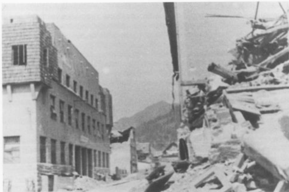
Ruševine Pavlinove hiše in poškodovana carinarnica (Fotografski arhiv GM Jesenice)
