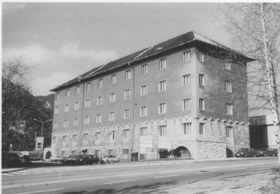
Stavba »pokojninskega sklada«, v kateri je imel sedež Raziskovalni oddelek več kot petintrideset let (Fotografski arhiv GM Jesenice)
