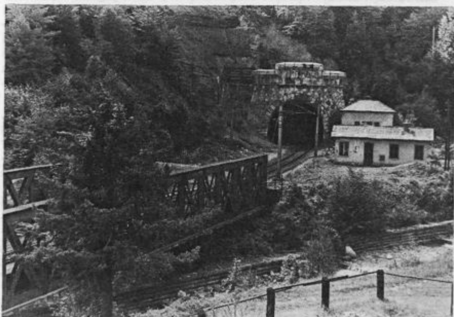
14. Karavanški predor s koroške strani
