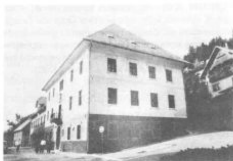
Vzhodni del fasade
