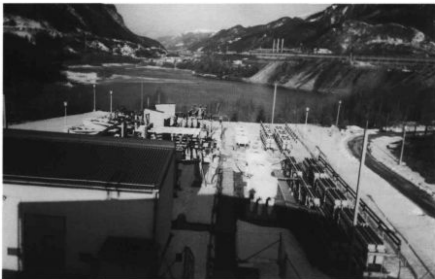
Kompensator 90 Mvar v ŽI
